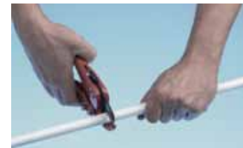
Отрезание трубы при помощи труборезных ножниц
